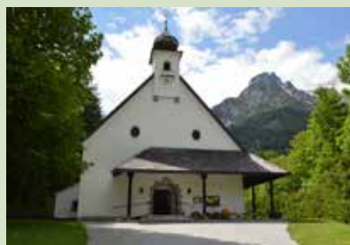
Pfarrkirche zur hl. Barbara, Tenneck, erbaut 1954
